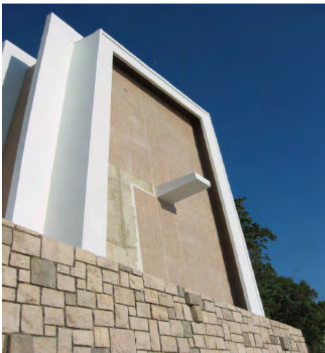
Foto 2: Un momento durante la aplicación del revestimiento cerámico con FLEXMORTEL. Puede verse también la parte de la estructura acabada con MASTERSEAL 325E.
