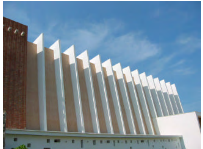
Foto 3: Una vista del lateral de la iglesia acabada con cerámica adherida con FLEXMORTEL. Puede verse también la zona acabada con MASTERSEAL 325E.
